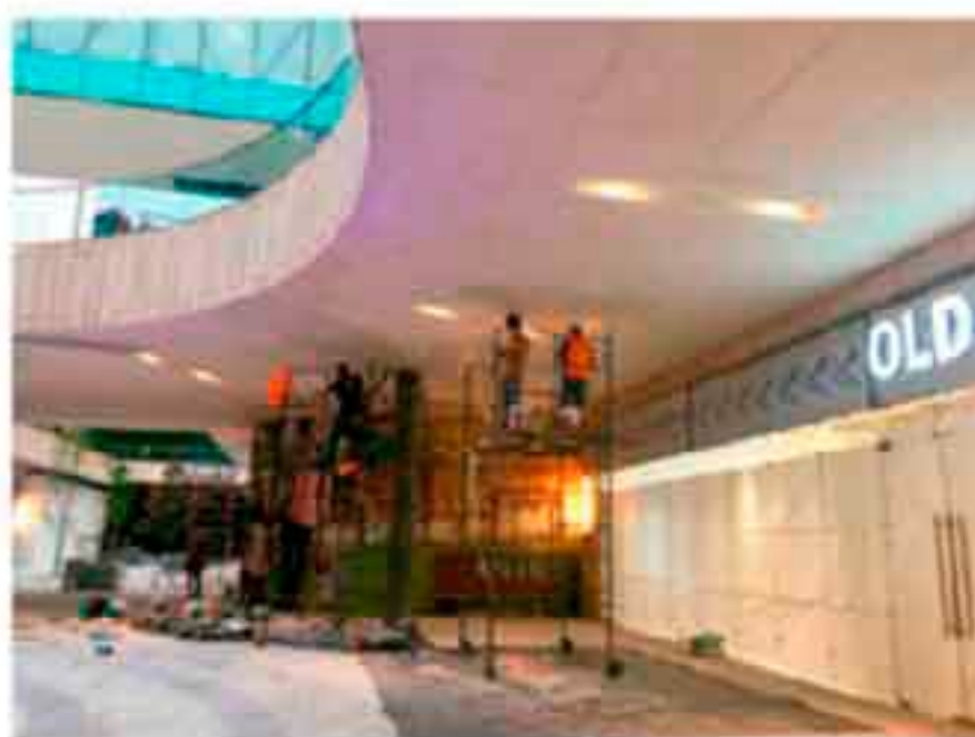
Colocación de Plafones.
