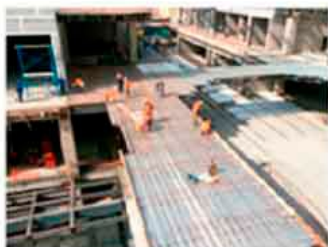
Colocación de Losacero.
