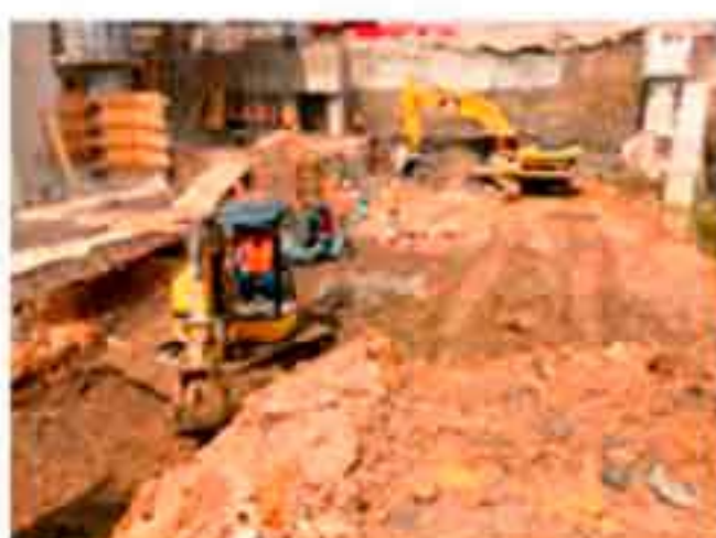
Excavaciones para Cisternas.
