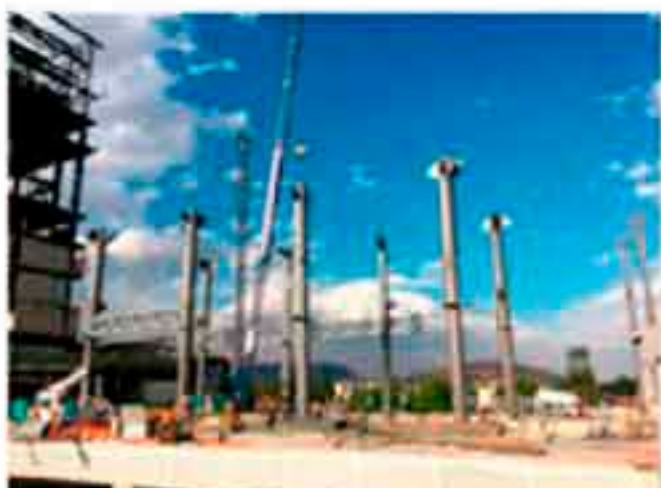
Montaje de Estructura Metálica.
