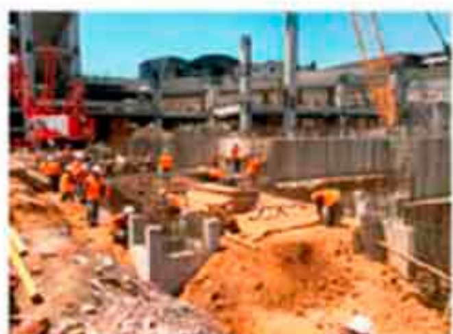
Construcción de Cisternas.
