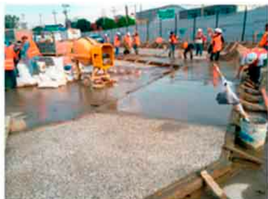
Construcción de Banquetas.
