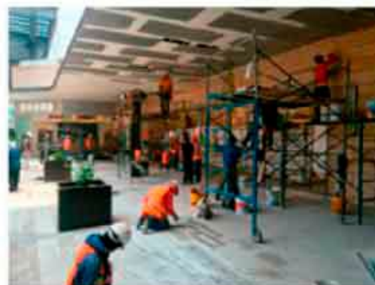
Colocación de Mármol y Plafones.
