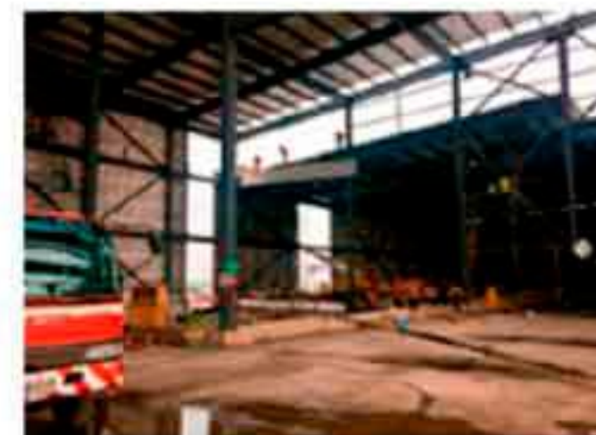
Estructura Metálica en Cinepolis.
