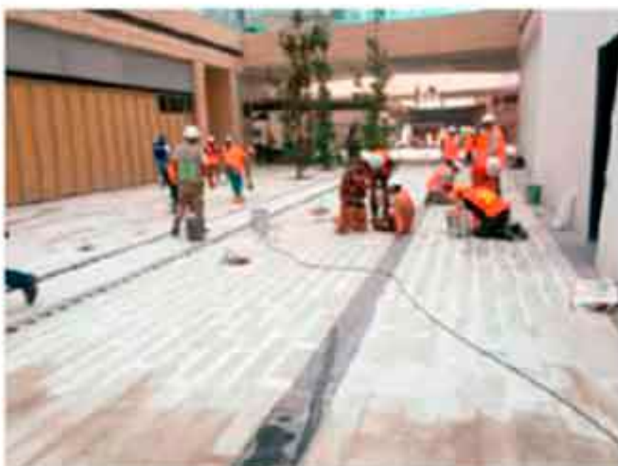
Colocación de Mármol.
