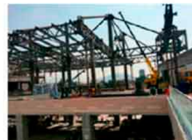
Montaje de Estructura Metálica.
