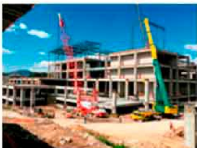
Estructura Metálica en Cinepolis
