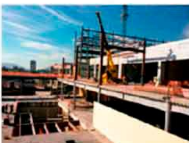
Fabricación y Montaje de Estructura Metálica.
