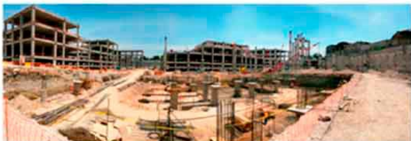
Construcción de capiteles, columnas.
