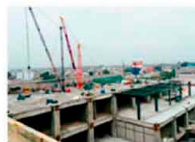
Montaje con Grúa Derryk.
