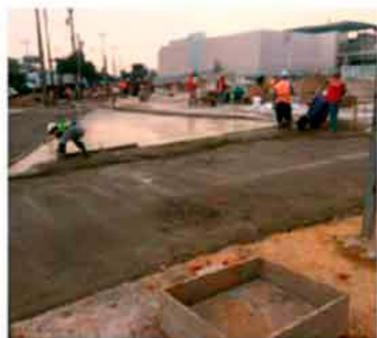
Construcción de Exteriores.
