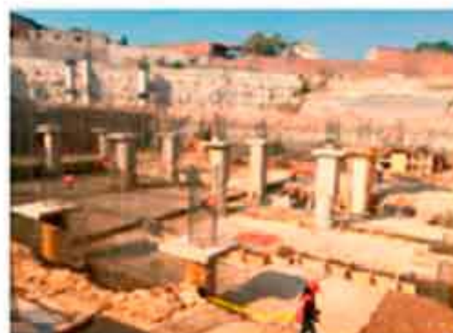
Construcción de Cisternas.
